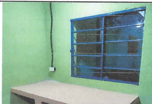
Foto 6: Se instalaron dos ventanas de metal corredizas con angular y hierro tipo té de 1" que proporciona seguridad además de la colocación de vidrio para que transfiera la claridad de la luz natural
