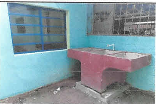
Foto 5: Se colocó la pila nueva de dos lavaderos sobre la mesa de concreto preparada para ese efecto.
