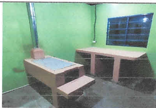
Foto 3: Estufa construida de concreto mas plancha de metal y chimenea junto a la mesa de trabajo de la cocina.
