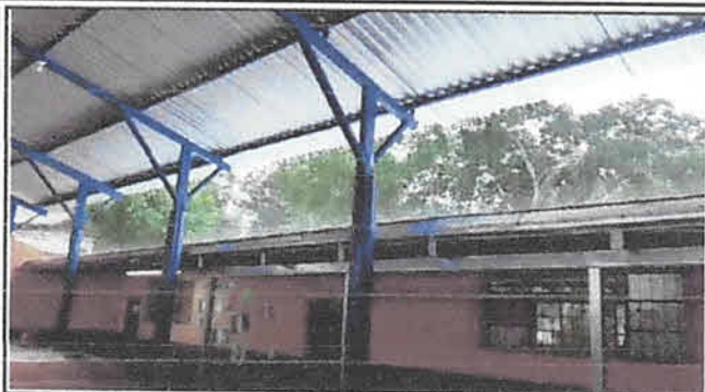
Foto 1: Se aplicó pintura anticorrosiva a toda la estructura metálica y se logró mejorar la ventilación e iluminación natural aumentando la altura de la estructura.
