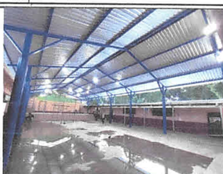
Foto 2: Se instaló lámina troquelada nueva en toda el área del salón sobre la estructura reparada
